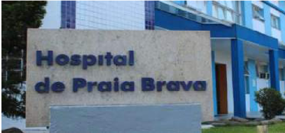
HOSPITAL DA PRAIA BRAVA (FEAM)
