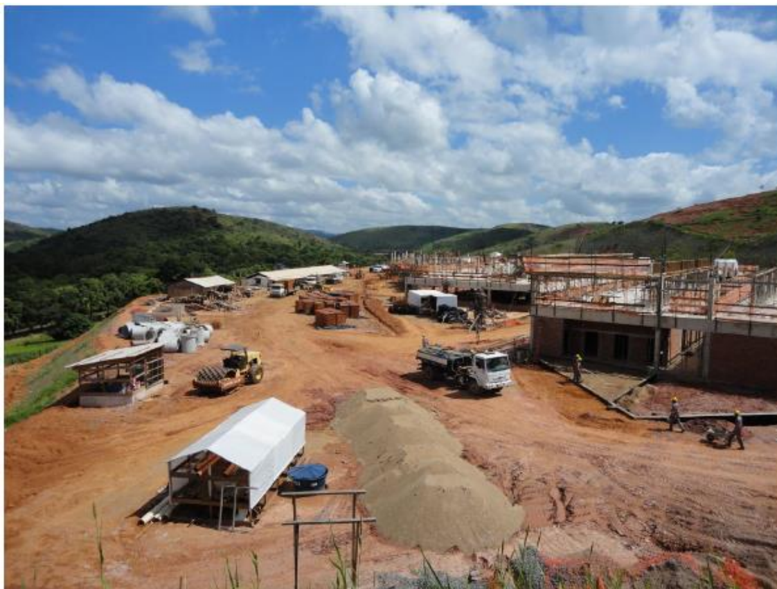
Obra do Hospital Regional de Governador Valadares
