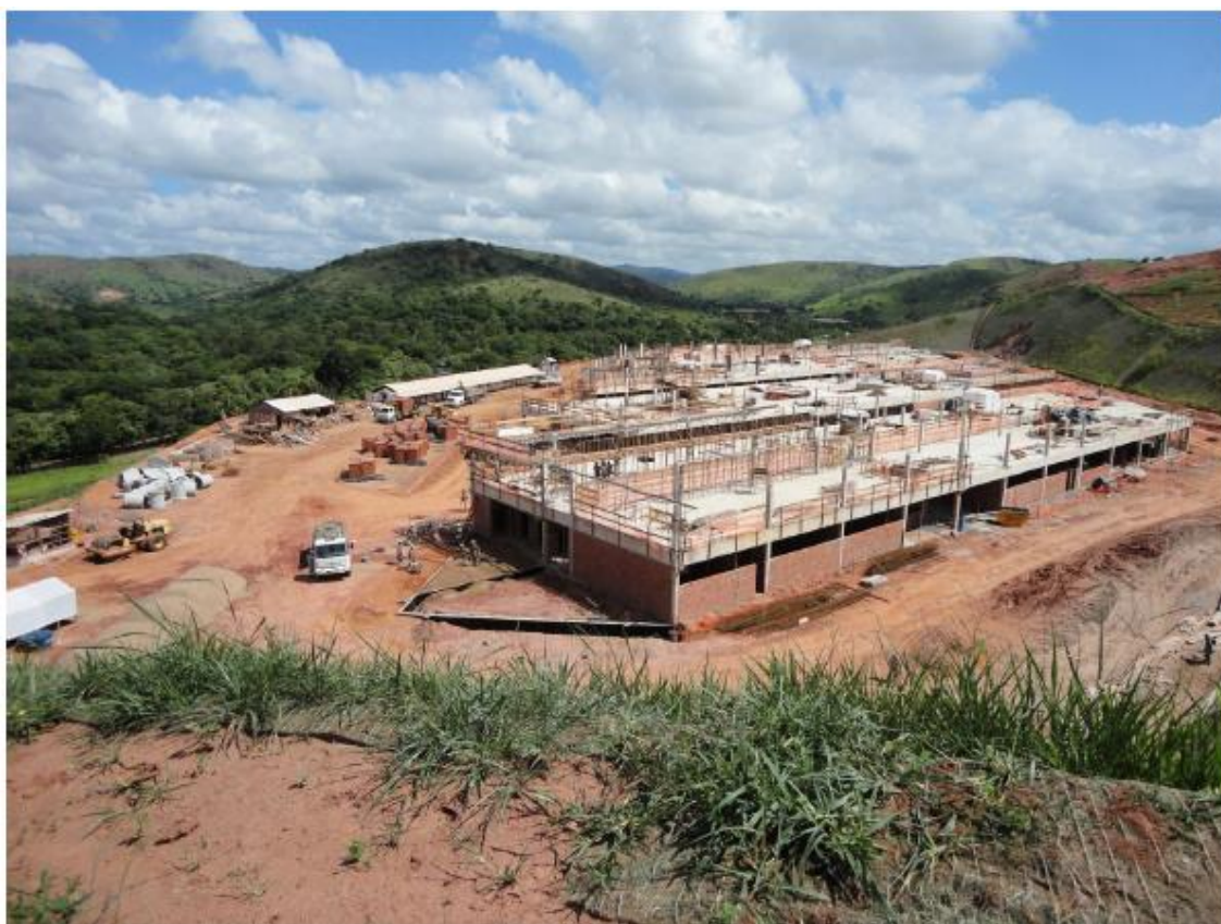
Vista geral da obra do Hospital Regional de Governador Valadares
